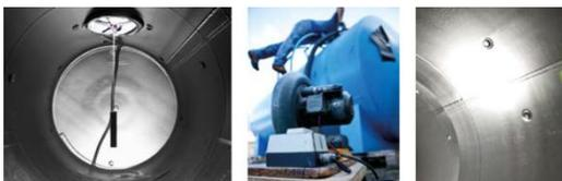
Zur Umrüstung z. B. stillgelegter Heizöl-, Diesel- oder Lagertanks aus Stahl, zu zuverlässigen und hochwertigen Regenwasserspeichern.
